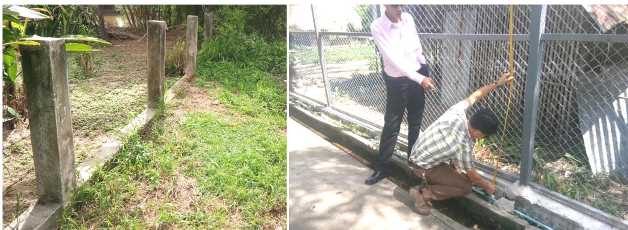
โครงการปรับปรุงกำแพงรั้วโรงเรียนเทศบาลฯ
