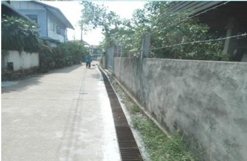
โครงการวางท่อระบายน้ำถนนประชาอุทิศ
