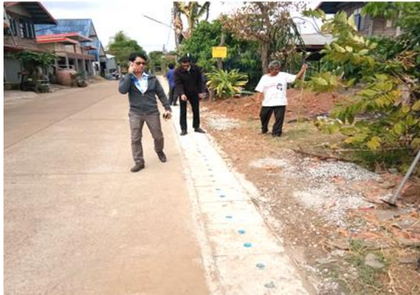
โครงการก่อสร้างถนน ค.ส.ล.ซอยแจ่มจันทร์-ลำห้วยยาม
