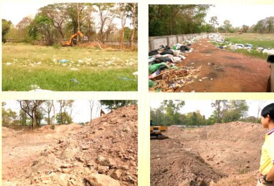
โครงการขุดหลุมกลบขยะบริเวณพื้นที่บ่อขยะเทศบาลตำบลคอนเือง งบประมาณ ๕๔,๔๐๐ บาท หน่วยงานที่รับผิดชอบกองช่าง
