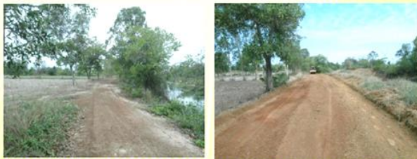
โครงการก่อสร้างถนน คสล.รอบลำห้วยแม่โคโร บ้านดอนเชียง (ต่อจากโครงการเดิม) งบประมาณ ๒๔๓,๙๐๐ บาท หน่วยงานที่รับผิดชอบกองช่าง
