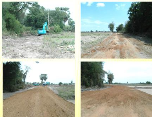
โครงการก่อสร้างถนนผิวจราจรลูกรังรอบป่าช้าดอนขาว บ้านสร้างแปน งบประมาณ ๑๕๗,๐๐๐ บาท หน่วยงานที่รับผิดชอบกองช่าง
