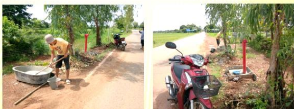
อุดหนุนขยายเขตประปาถนนทางหลวงท้องถิ่นสาย บ้านสร้างแป้น - บ้านศาลโกน บริเวณศูนย์สาธิต ๕ ถึงร้านกล้วยเดี่ยว บ้านสร้างแป้น งบประมาณ ๑๕๐,๐๐๐ บาท หน่วยงานที่รับผิดชอบกองช่าง
