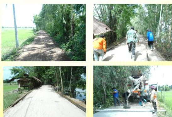
โครงการก่อสร้างถนนคสล.เลียบลำห้วยโพธิ์ทองบ้านสร้างตู๋ งบประมาณ ๓๓๙,๕๐๐ บาท หน่วยงานที่รับผิดชอบกองช่าง
