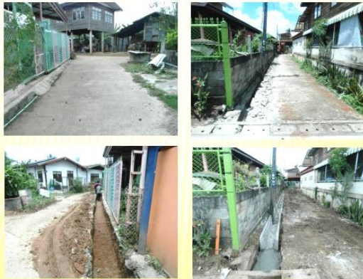
โครงการก่อสร้างระบายน้ำ คล.ชอยเชื่อมถนนพวนพร้าว บ้านดอนเชียง งบประมาณ ๑๔๕,๐๐๐ บาท หน่วยงานที่รับผิดชอบกองช่าง
