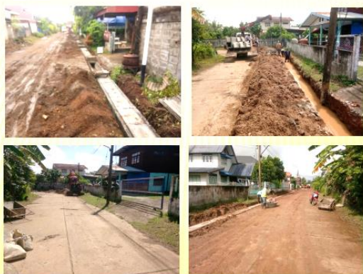
โครงการก่อสร้างรางระบายน้ำ คสล. ระบายน้ำอาคารใต้ดินถนนสร้างคู่ ๔ งบประมาณ ๓๒๒,๐๐๐ บาท หน่วยงานที่รับผิดชอบกองช่าง
