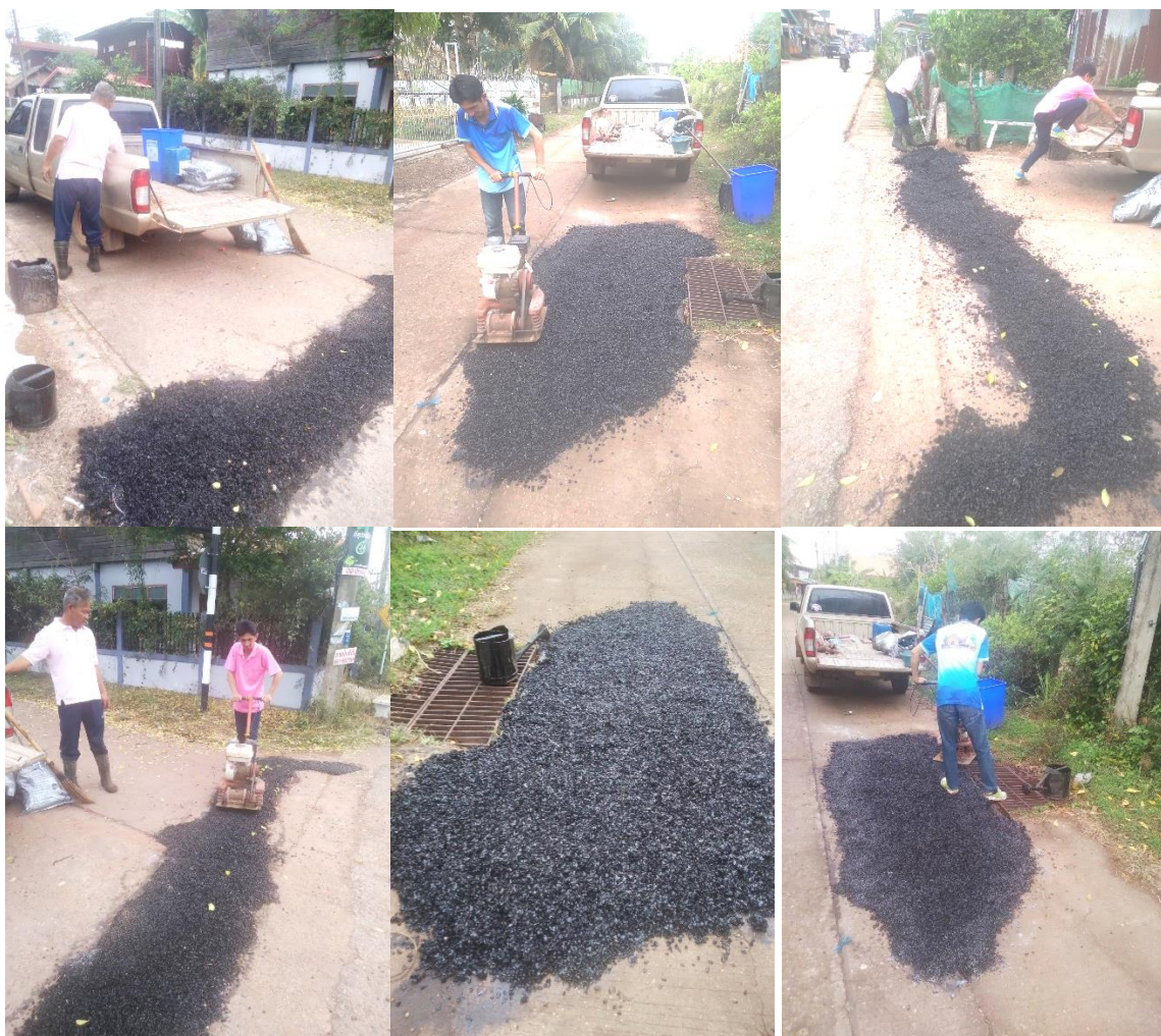
กิจกรรมงานซ่อมแซมถนน
