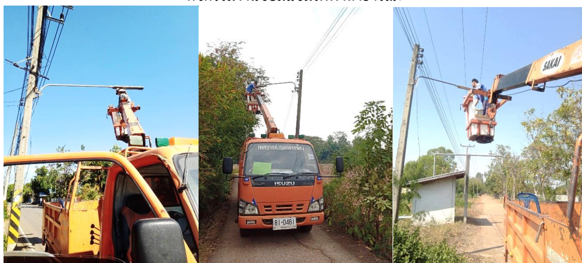
กิจกรรมงานซ่อมแซมไฟฟ้าสาธารณะ
