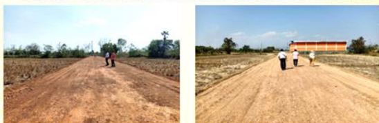
โครงการก่อสร้างถนนผิวจราจรลูกรังเชื่อมทางหลวงแผ่นดิน ทล.๒๒ บ้านดอนเชียง งบประมาณ ๔๐๑,๐๐๐ บาท หน่วยงานที่รับผิดชอบกองช่าง
