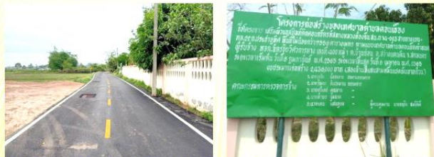
โครงการก่อสร้างระบายน้ำ คล.ชอยพริเจริญ บ้านสร้างแป้น งบประมาณ ๖๙,๗๐๐ บาท หน่วยงานที่รับผิดชอบกองช่าง
