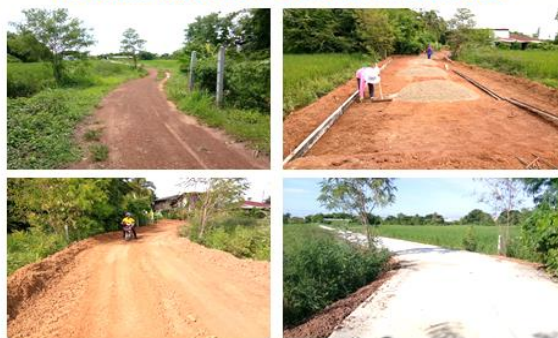
โครงการก่อสร้างถนน คสล. ซอยเชื่อมทางหลวงท้องถิ่น งบประมาณ 138,200 บาท หน่วยงานที่รับผิดชอบกองช่าง
