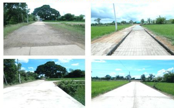
โครงการก่อสร้างถนน คลส.ซอยพุทธธรรม บ้านดอนเจียง งบประมาณ 197,000 บาท หน่วยงานที่รับผิดชอบกองช่าง
