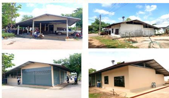
โครงการปรับปรุงอาคารอเนกประสงค์ชุมชน 5 บ้านดอนเจียง งบประมาณ 200,000 บาท หน่วยงานที่รับผิดชอบกองช่าง
