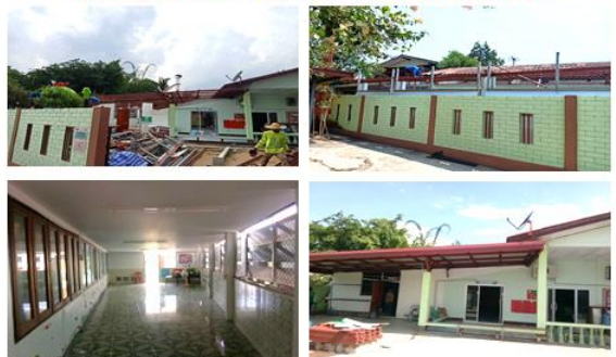
โครงการปรับปรุงอาคารศูนย์พัฒนาเด็กเล็กเทศบาลตำบลดอนเจียง งบประมาณ 235,00 บาท หน่วยงานที่รับผิดชอบกองช่าง
