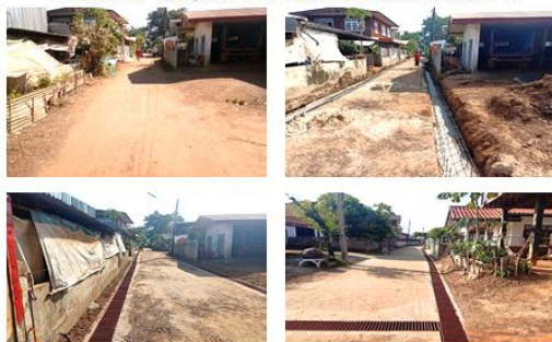
โครงการก่อสร้างรางระบายน้ำ คลส.ซอยพันธุธานี งบประมาณ 251,000 บาท หน่วยงานที่รับผิดชอบกองช่าง
