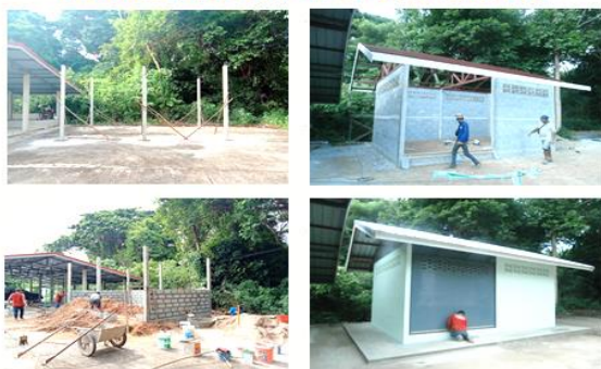
โครงการก่อสร้างห้องเก็บของบริเวณป่าช้าดอนขาว บ้านสร้างแป้น งบประมาณ 166,000 บาท หน่วยงานที่รับผิดชอบกองช่าง
