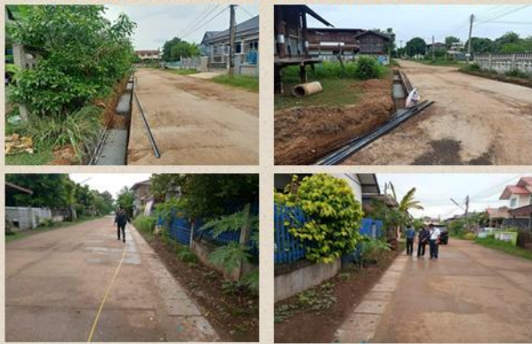
โครงการก่อสร้างรางระบายน้ำ คสล.ระบบธนาคารน้ำใต้ดิน ถนนสร้างคู่ 4 งบประมาณ 316,000 บาท หน่วยงานที่รับผิดชอบกองช่าง
