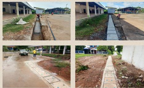
โครงการก่อสร้างรางระบายน้ำ คสล.ระบบธนาคารน้ำใต้ดิน บริเวณข้างศาลาอเนกประสงค์ บ้านสร้างคู่ งบประมาณ 128,000 บาท หน่วยงานที่รับผิดชอบกองช่าง
