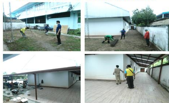
โครงการต่อเติมอาคารป้องกันและบรรเทาสาธารณภัย ทต.ดอนเจียง งบประมาณ 269,700 บาท หน่วยงานที่รับผิดชอบกองช่าง
